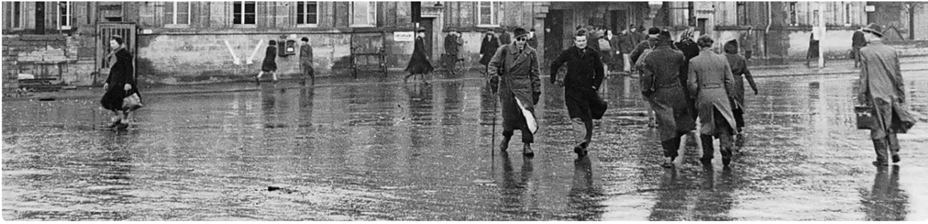
Bombenschäden am Göttinger Bahnhof 1945.
