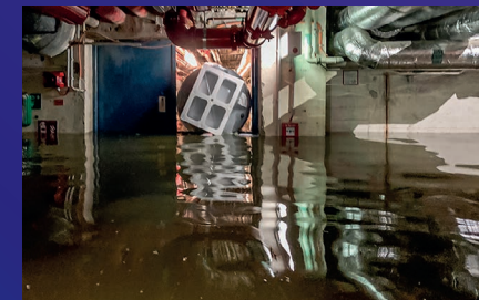
... und im Keller von Gebäude 30
