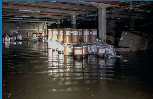
... im Keller von Gebäude 61a
