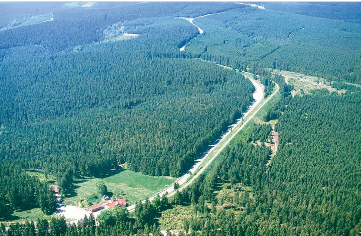
Bild 16 Der große Harz-Aquädukt Sperberhaier Damm: Die größte organisatorische Leistung der Oberharzer Bergleute über Tage zeigt sich am eindrucksvollsten im Luftbild.
