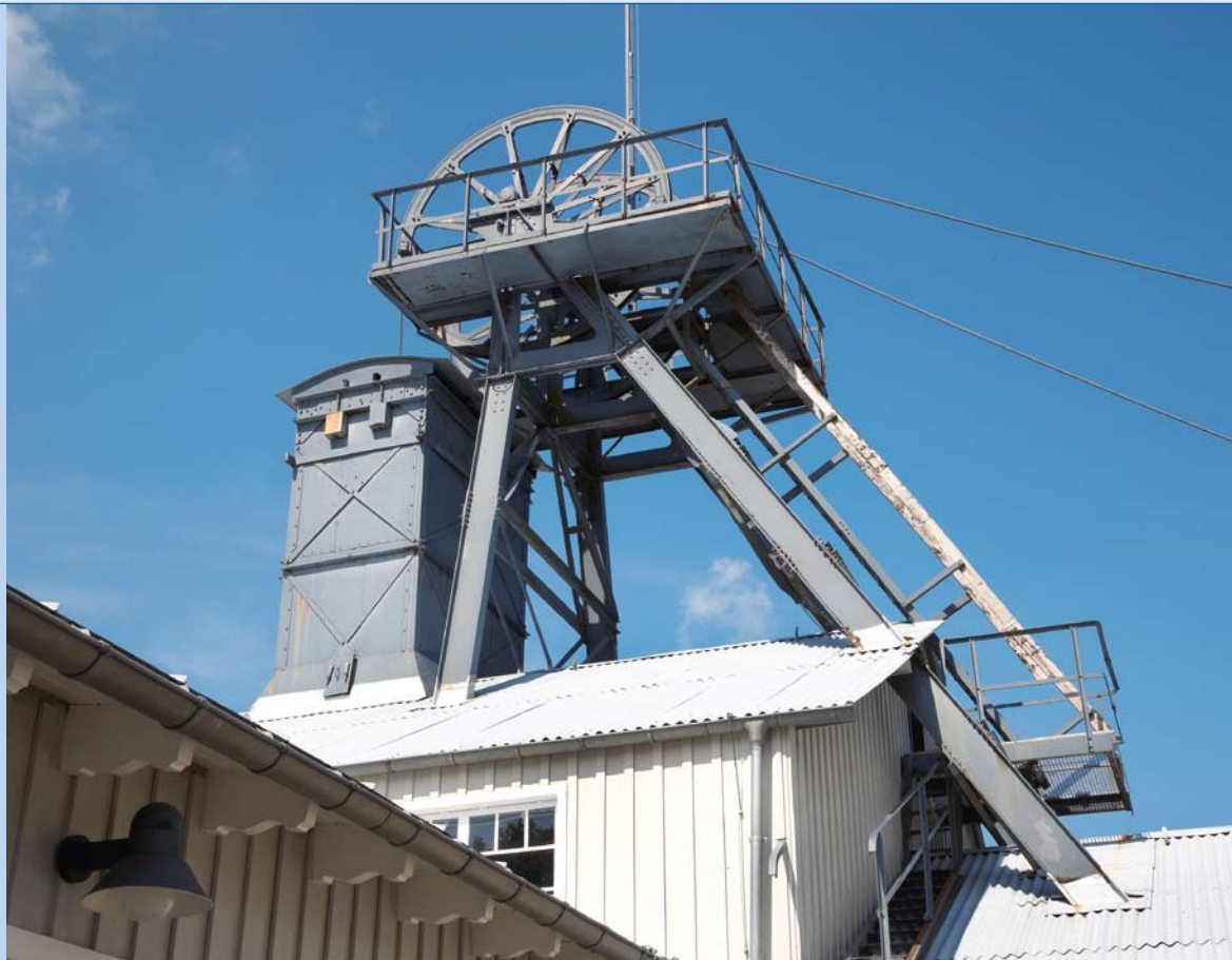
Bild 9 Fördergerüst des Kaiser- Wilhelm-Schachtes auf dem Gelände des Betriebshofs Clausthal der Harzwasser- werke GmbH. Die originalgetreu restau- rierten Tagesanlagen stellen heute eine vollständig erhaltene übertägige Erz- bergwerksanlage aus den 1880er Jahren dar.
