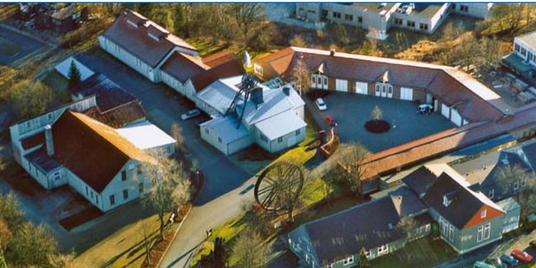
Bild 17 Betriebs Hof Clausthal der Harzwasserwerke GmbH: Dieser Betriebs Hof ist auf dem Gelände des ehemaligen Kaiser-Wilhelm-Schachtes untergebracht, einem Bergwerk des späten 19. Jahrhunderts.
